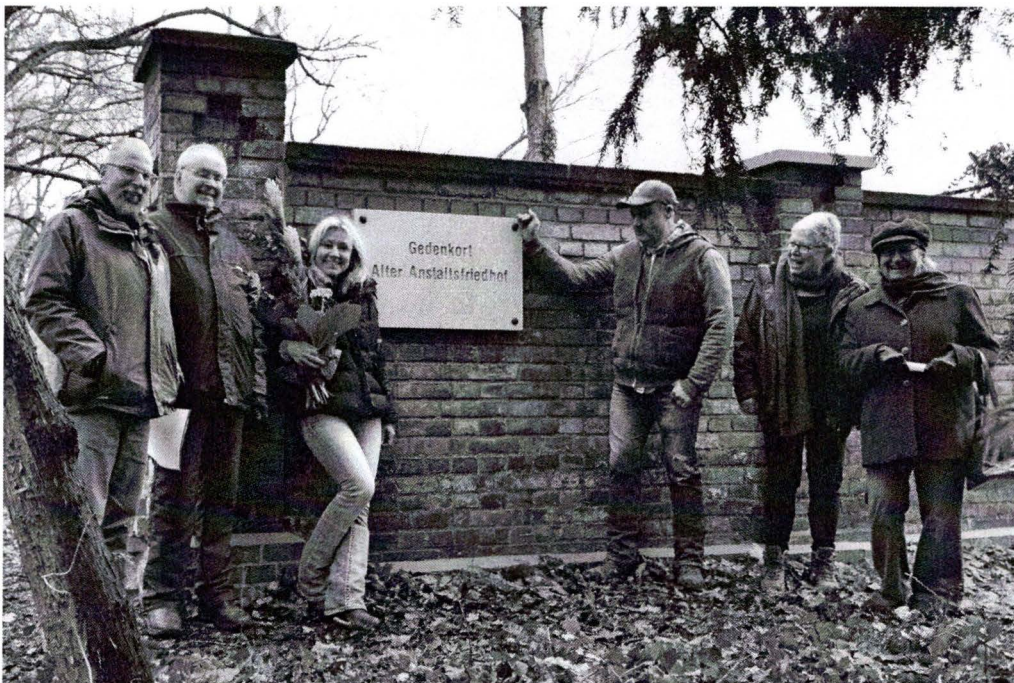
Bauabnahme der fertigen Mauer und der Gedenktafel mit Vertretern des Freundeskreises Alter Anstaltsfriedhof, des Förderkreises Reinickendorf e.V. und der Firma Breuer, die die Instandsetzung ausgeführt hat.
