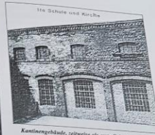
Kantinegebäude, teilweise als erste Schule von Waidmannslust und für ev. Gottesdienste genutzt (um 1900) [SKS]
