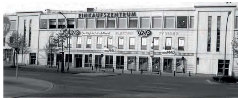
Scharnweberstr. 139, „Der Clou“ (1993) (Foto: K. Schlickeiser)
